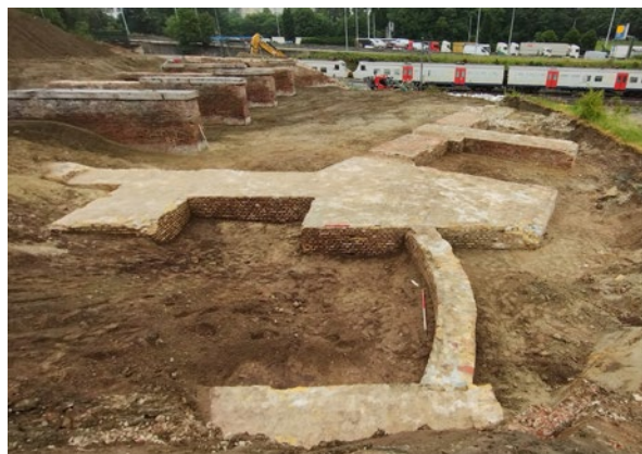
Zicht op de hoek in de caponnière, uitgewerkt in massief baksteen metselwerk.
