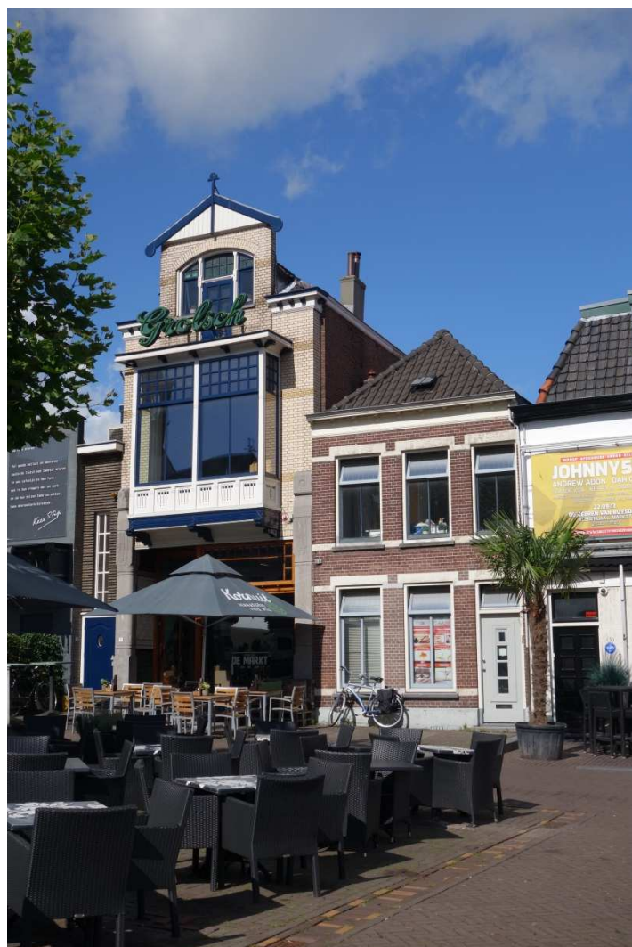
Figuur 26. Links een winkelwoonhuis uit het begin van de 20e eeuw aan de Markt (foto: CeesJan Frank).
