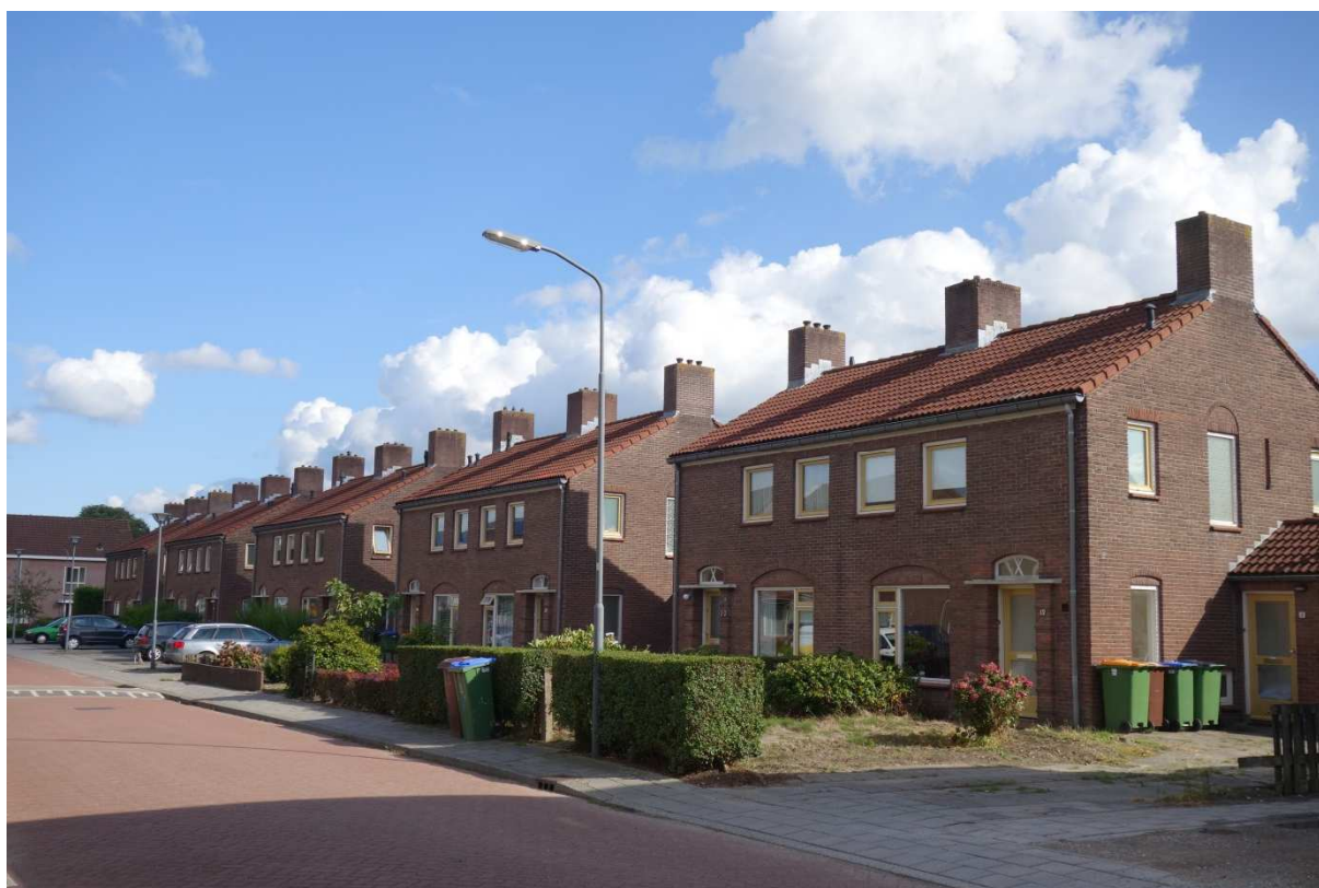
Figuur 25. Kleinschalige woonhuisbebouwing uit de jaren 50: duplexwoningen aan de Eenvoudlaan (foto: CeesJan Frank).
