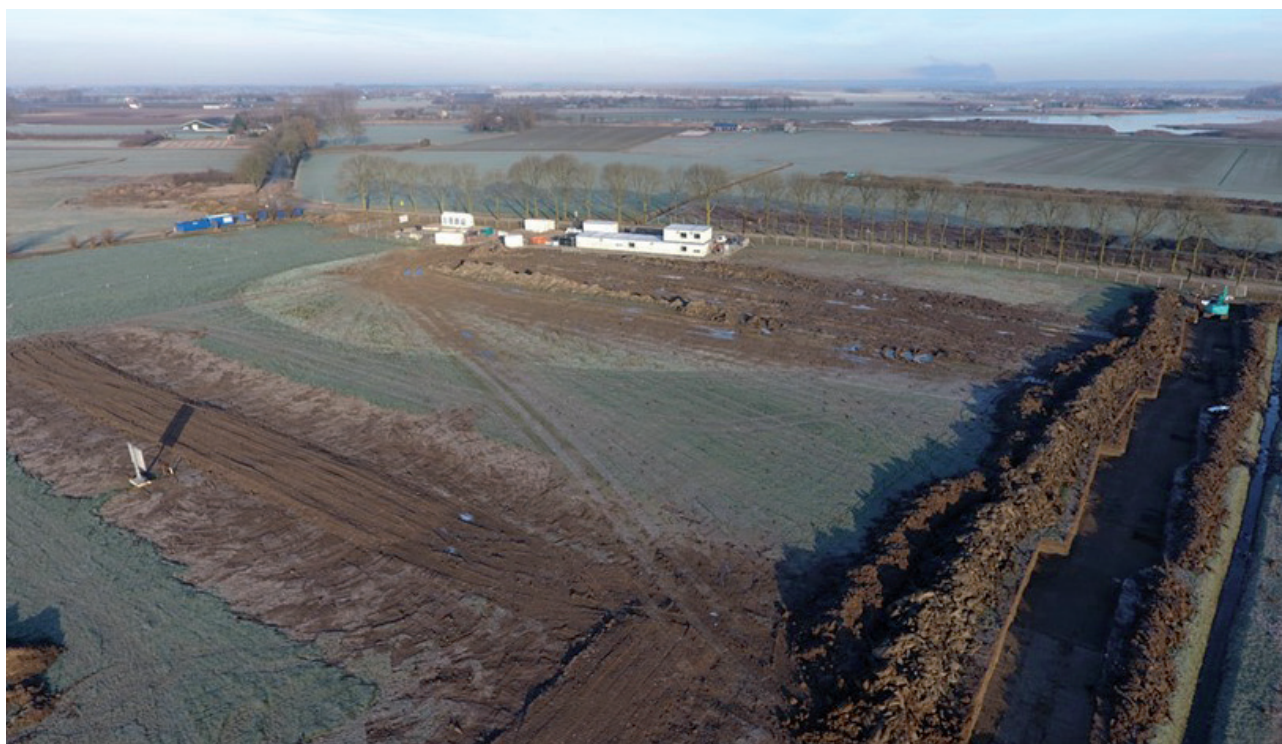
Figuur 2.5. Ketenpark en andere logistieke voorzieningen vanuit het zuiden gezien. Links de zuiveringsinstallatie van de bemaling.
